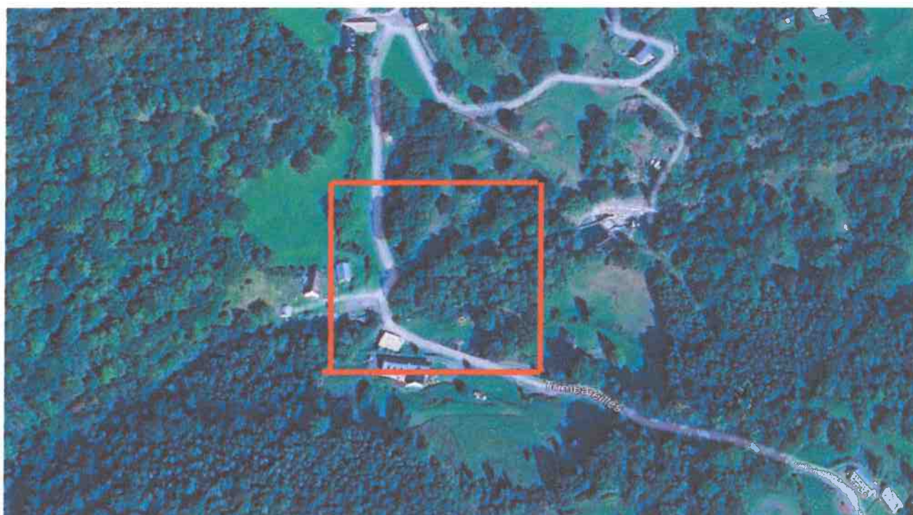
Vue aérienne du site de la centrale hydroélectrique du SEPT sur le territoire de la commune de GAVARNIE GEDRE
