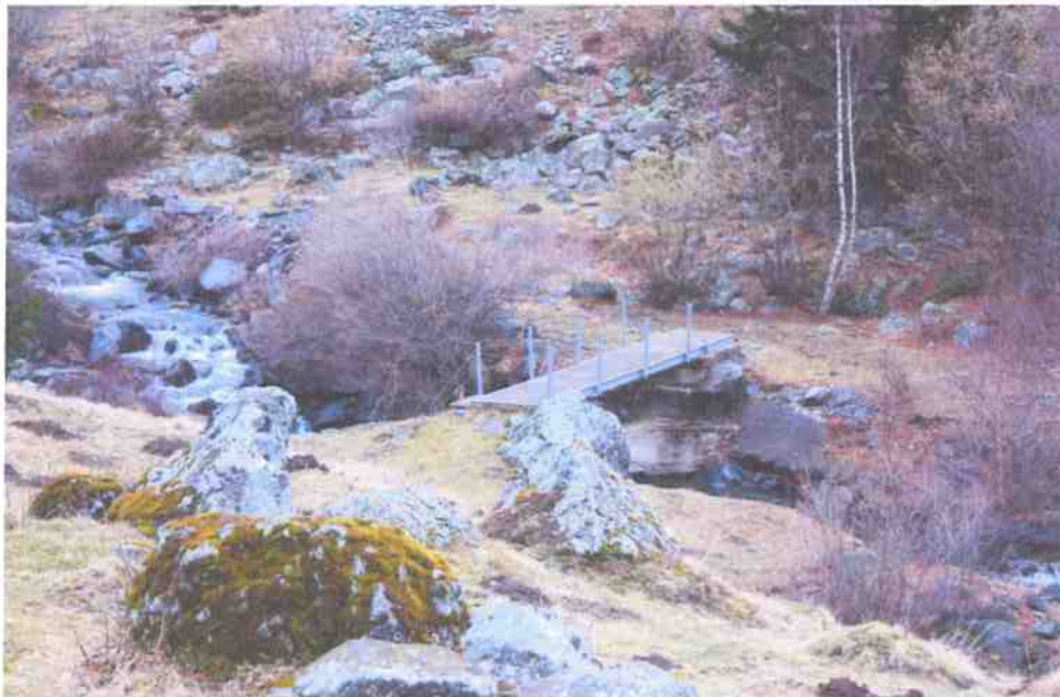
Vue du site des granges de Bué (seuil et prise d'eau)
