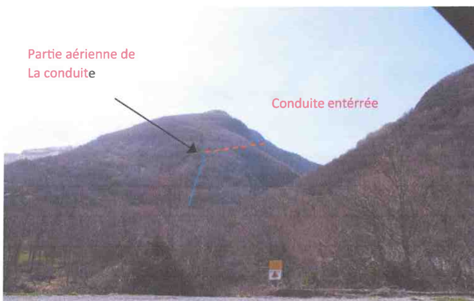
Vue depuis la RD n° 921 (conduite forcée)
